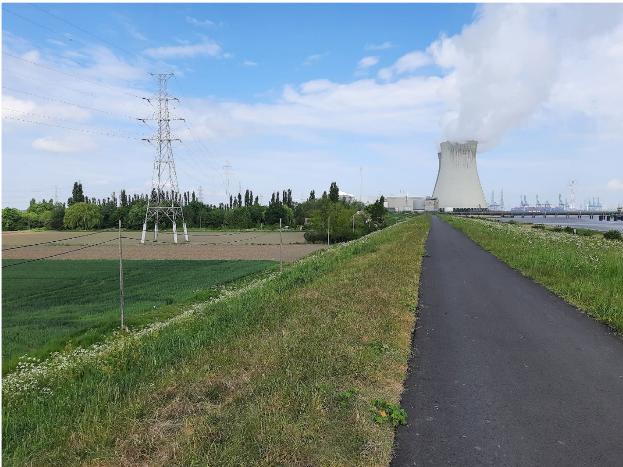
Figuur 19 Door de verhoogde Scheldedijk worden vogels die vanaf de Schelde in westelijke richting vliegen 'opgestuwd' waardoor ze (min of meer) op de hoogte van de geleidings- en waakdraden vliegen van de vlakbij gelegen lijn die parallel aan de Scheldedijk loopt. Door de geringe afstand tussen de Scheldedijk en deze hoogspanningslijn kunnen (vooral grotere, minder wendbare) vogels hun aanvlieghoogte niet meer tijdig aanpassen, waardoor ze in botsing komen met deze hoogspanningslijn. 7 mei 2022, Doel (foto: Dominique Verbelen).
