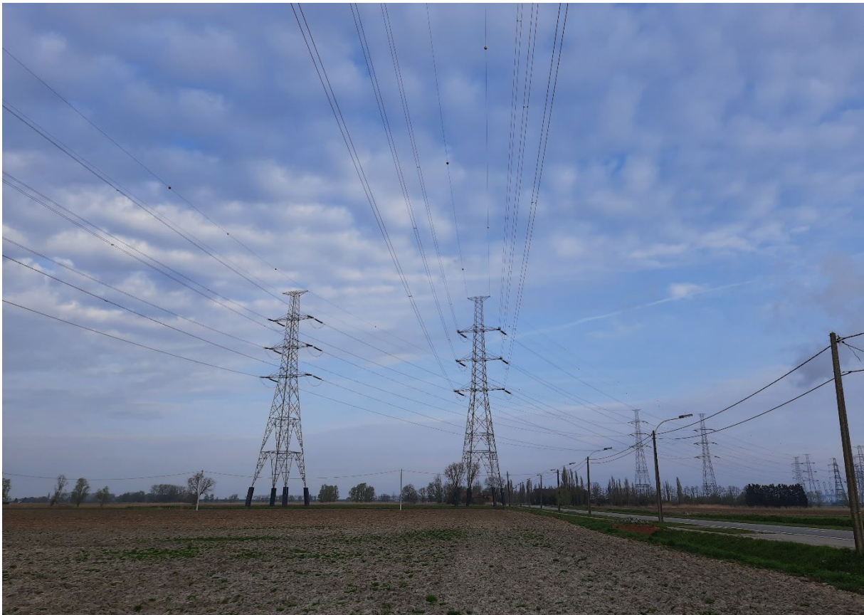
Figuur 2 De twee hoogspanningslijnen langsheen de Oostlangeweg. Let op de spacers (op de geleidingsdraden) en op de luchtverkeersbakens (op de waakdraden), 22 januari 2022, Doel (foto: Dominique Verbelen).
