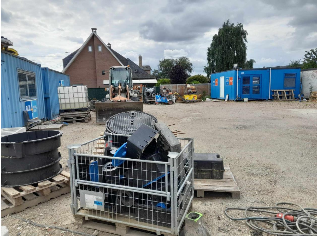
Figuur 10: Door de wegenwerken in de Driesstraat is de eventuele vegetatie die hier op het perceel aanwezig was volledig verdwenen. Het perceel dient dus na de werken opnieuw ingericht te worden (foto: David De Grave – 18/07/23).
