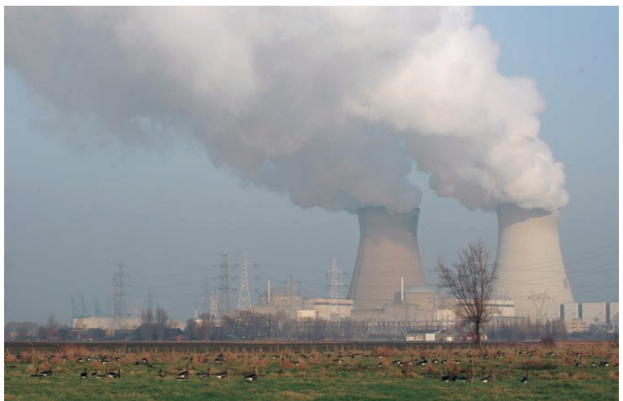
Kolganzen Anser albifrons in de schaduw van de koeltorens te Doel (© Geert Spanoghe)
