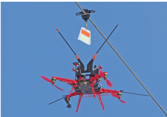
Figuur 14. Door FireFly's aan te brengen met drones kan er veel efficiënter en goedkoper worden gewerkt, zeker in moeilijk toegankelijk terrein (bv. in berggebieden of boven waterpartijen). (© Wolfgang Bartke/Bartke Kennzeichnungssysteme) By applying FireFly's with drones interventions can be done in a less expensive and more efficient way, especially in difficult-to-access terrain (e.g. in mountainous areas or above water).
