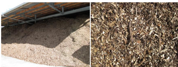
Figuur 6: Een opslagruimte voor houtsnippers met een volume van 2500m 3 is voldoende om de ganse jaarvoorraad op te slaan.
