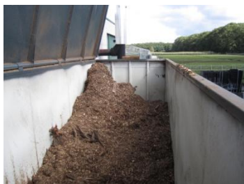
Figuur 2: een container met een volume van 37m 3 zorgt voor de directe bevoorrading van de verbrandingsinstallatie.
