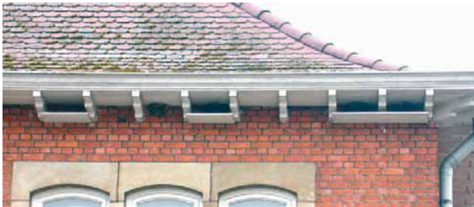
Figuur 83. Eenvoudige oplossing, maar niet ideaal: mestplankjes té dicht; vergroot de kans als nestplaats voor stadsduiven en vermindert de aantrekkelijkheid voor huiszwaluwen (Hasselt).
