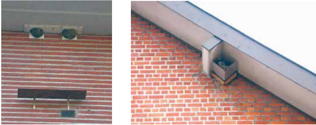
Figuur 81-82. Mestplankje op voldoende afstand (links) en té dicht (rechts), want nu nestplaats voor stadsduiven.
