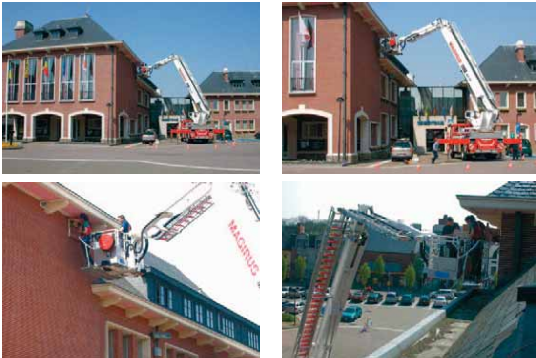
Figuur 54-57. Plaatsing van nestbak aan het gemeentehuis van Tessenderlo.
