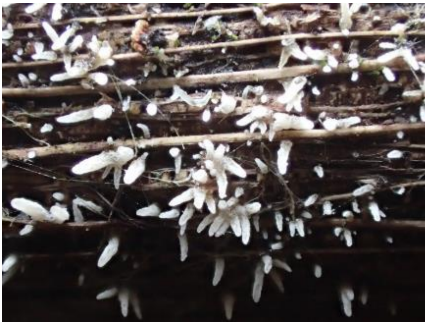
Foto: Marc Detollenaere
