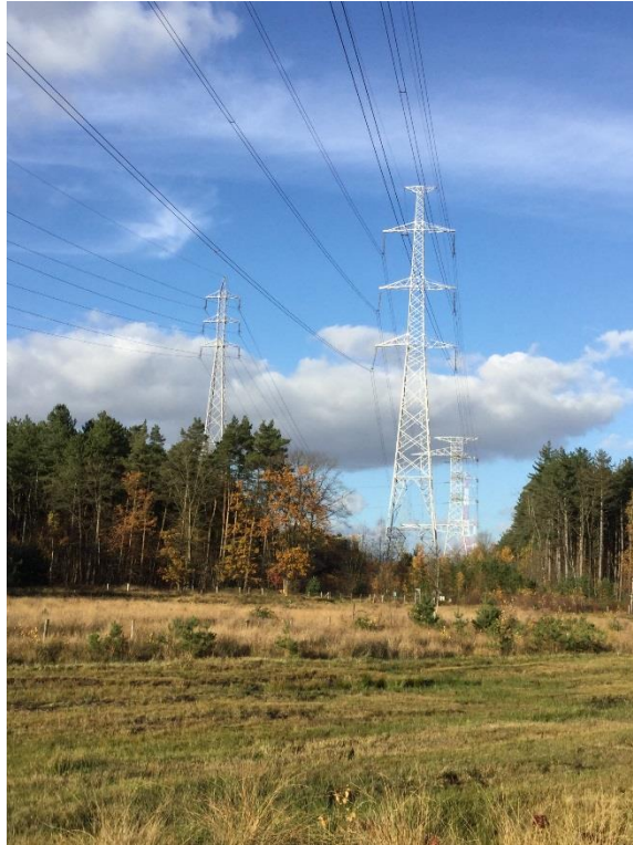
Figuur 8: Vegetatie onder de hoogspanningslijn in het Munsterbos (foto: Ward Cielen).
