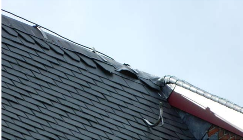
Foto 9: Een wat omgebogen loodslab in de nok van het dak die dienst doet als in- en uitvliegopening van de kolonie Laatvliegers in de kerk van Lippelo, 5/09/2011 (foto Erik De Keersmaecker)
