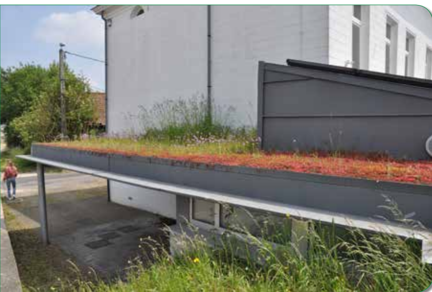
Figuur 1. Een extensief groendak op een carport. Microvariatie in omgevingscondities (zon-schaduw, droog-vochtig) beïnvloeden duidelijk de vegetatiesamenstelling. (foto: Frederik Lerouge)
