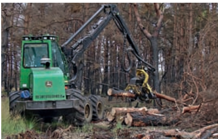
Verwijderen van de verbrande bomen. Foto: Luc Crols
