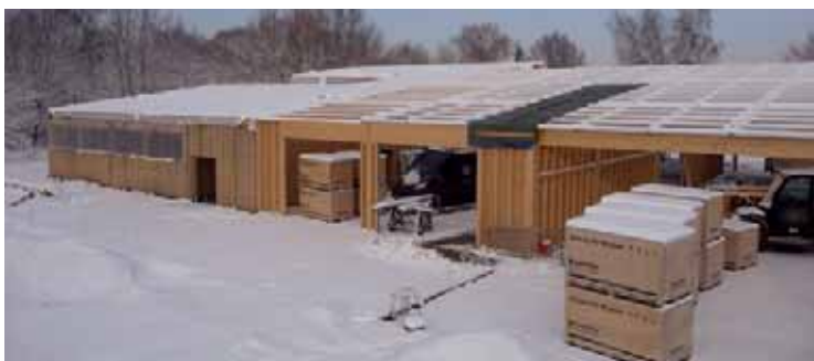
De loods in opbouw
