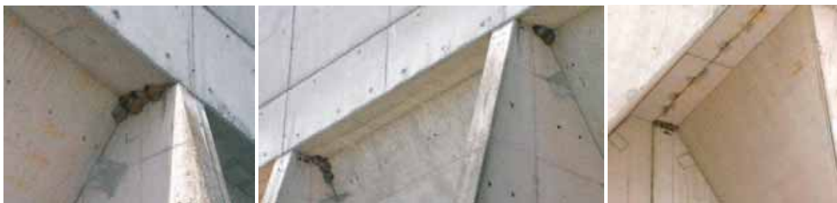
Figuur 18. Voorbeeld van een gegeerde industriële betonnen constructie (Sibelco Lommel).
