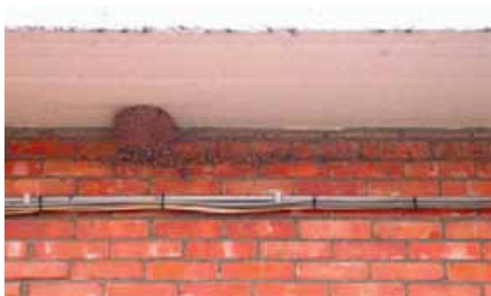
Figuur 75: Kabels die te diep onder de dakrand hangen vormen een groot verlies aan potentieel voor huiszwaluwnesten ! Met wat aandacht kan men kabels precies op de goede afstand (12 cm) bevestigen om als steun te kunnen dienen voor heel veel nesten.
