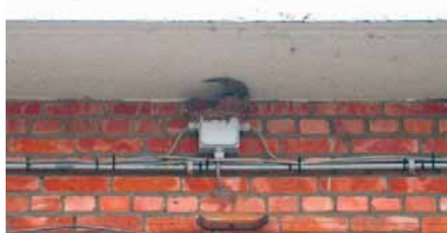
Figuur 75: Kabels die te diep onder de dakrand hangen vormen een groot verlies aan potentieel voor huiszwaluwnesten ! Met wat aandacht kan men kabels precies op de goede afstand (12 cm) bevestigen om als steun te kunnen dienen voor heel veel nesten.
