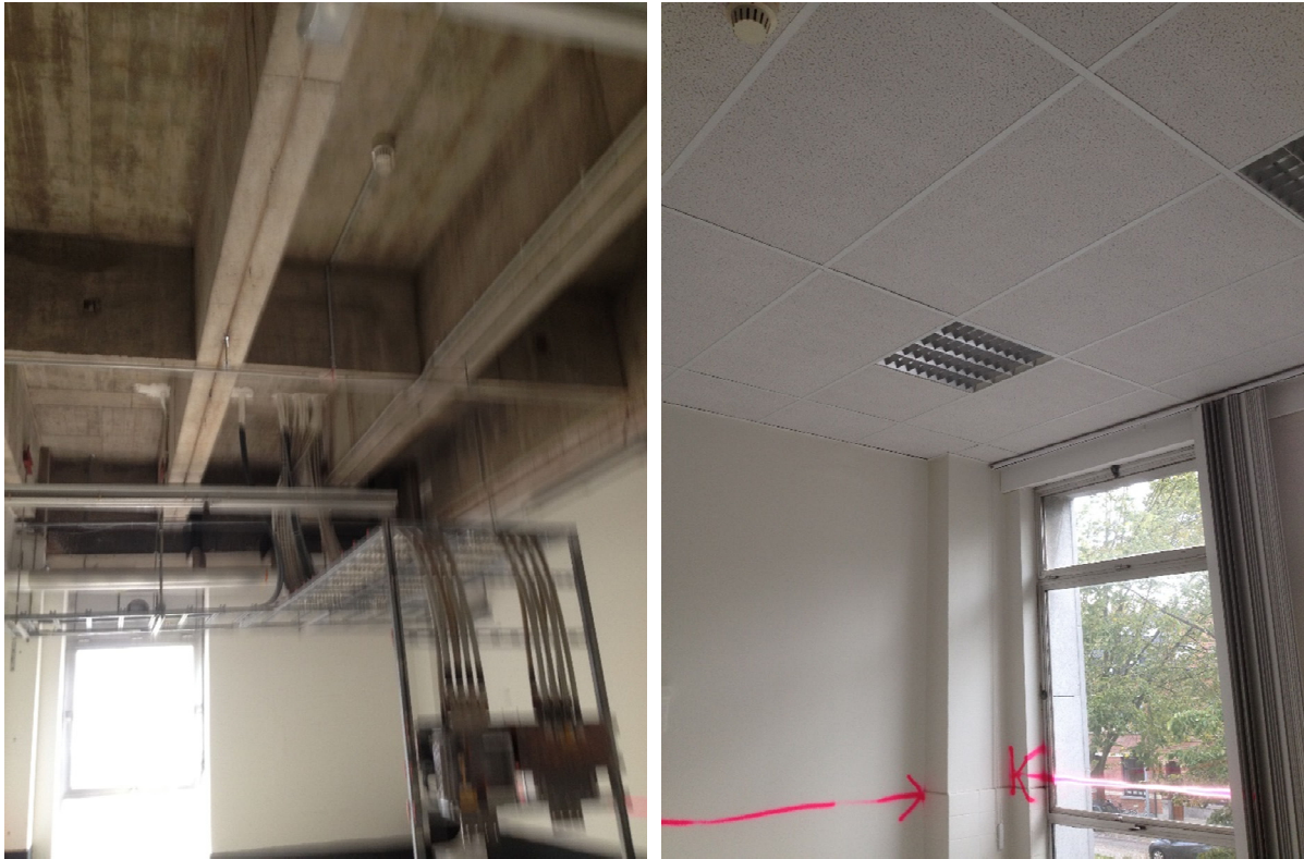
Figuur 5. Links: Opbouw plafond, met omgekeerde U-vormige compartimentering. Rechts: In veel lokalen is onder deze plafonds een 'vals plafond' gemaakt waardoor een grote ruimte ontstaat waar vleermuizen ongestoord kunnen verblijven.
