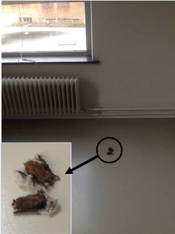
Figuur 8. Dode vleermuizen in het kantoorgebouw.
