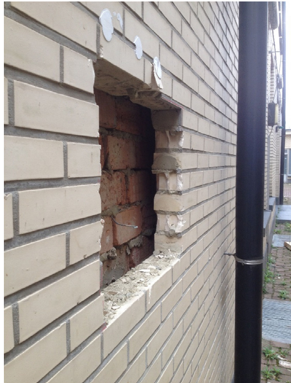
Figuur 4. Links: Uitzettingsvoeg tussen gebouw A en gebouw B. Rechts: opbouw van de muur met spouw (hier gebouw C).
