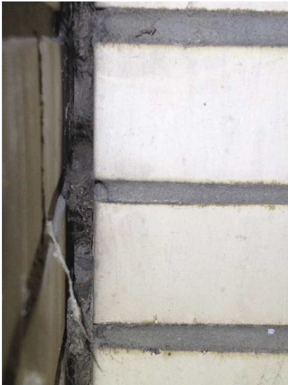
Figuur 4. Links: Uitzettingsvoeg tussen gebouw A en gebouw B. Rechts: opbouw van de muur met spouw (hier gebouw C).
