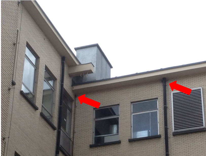
Figuur 11. Aanduiding van de waargenomen invliegopeningen in het gebouw. De ene plaats bevindt zich in de hoek van de aansluiting van de twee gebouwdelen, de tweede plaats bevindt zich aan de opening waar de hemelwaterafvoer uit de dakoversteek komt. (22 september 2020)
