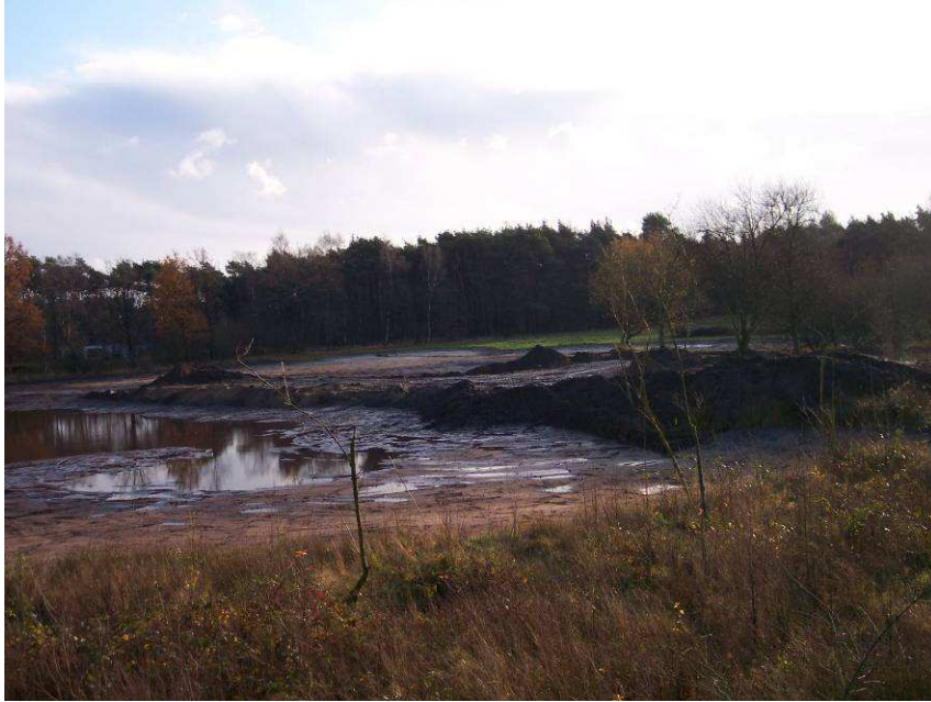
Figuur 2.3 Graafwerken in functie van venherstel in het Turnhouts Vennengebied.
