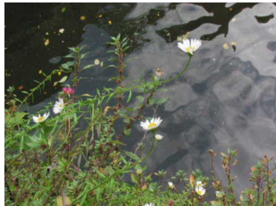
Muurfijnstraal op kanaalmuur
