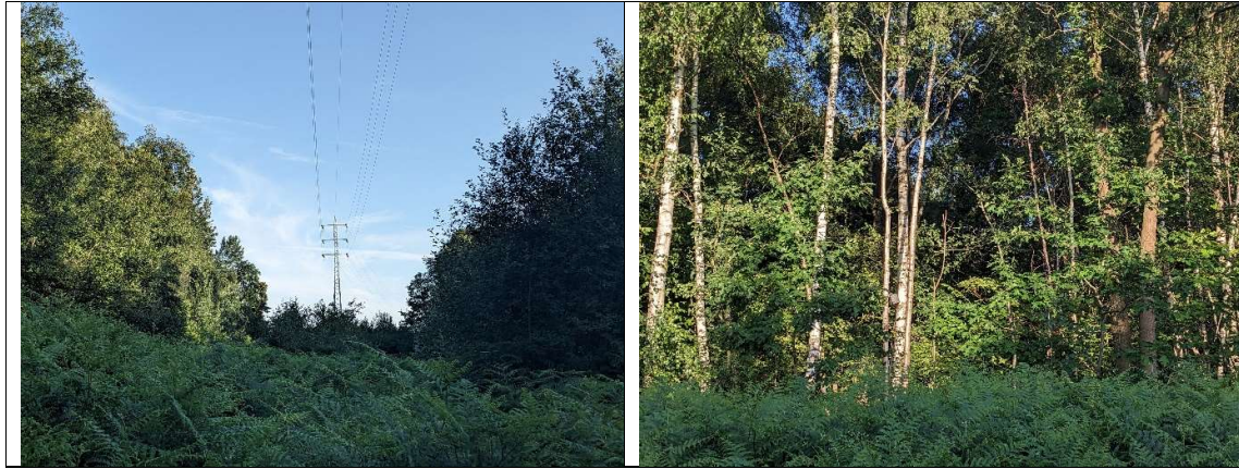
Figuur 21: Hoogspanningslijn en omliggende vegetatie te Kortenaak
