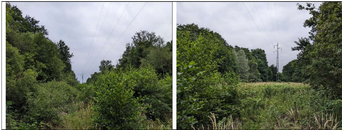
Figuur 22: Hoogspanningslijn en omliggende vegetatie te Zolder
