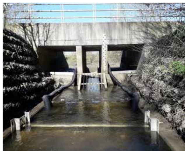
Figuur 3. Locatie van de monding van de Melsenbeek op de Tjarm (rode bol) ten zuiden van Gent (links). Zicht op het sleufval-retoursysteem vanaf de Melsenbeek (rechts, © Provincie Oost-Vlaanderen). Zichtbaar zijn de sleufval (vooraan), de retourbuizen, en de Tjarm (achteraan).
