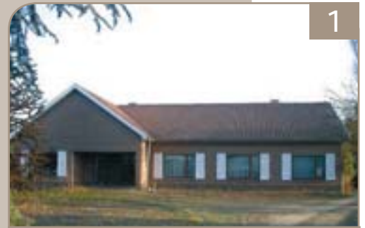
1 jaarverblijf van dwervleermuizen: 's zomers achter de luijkjes en kraamkamer in de rolluikkast, 's winters in de spouw.
